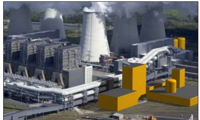
Jänschwalde power plant
